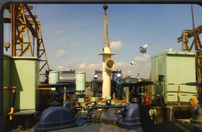
Montaje de equipos en sitio
