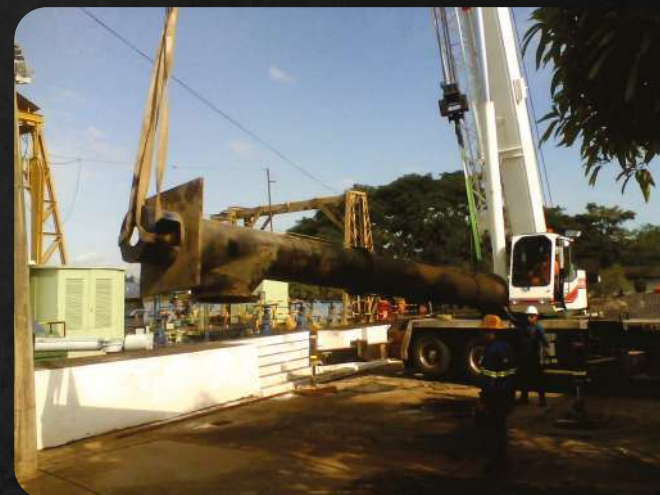
Desmontaje de piezas y equipos
