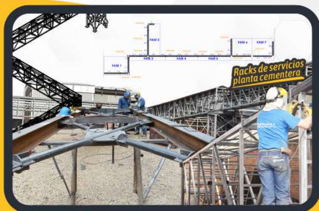
ESPECIALISTAS EN DISEÑO FABRICACIÓN Y MONTAJE DE ESTRUCTURAS METÁLICAS INDUSTRIALES Y ARQUITECTÓNICAS
