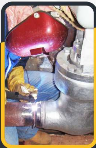
CAMBIO DE VÁLVULAS DE ALTA PRESIÓN
