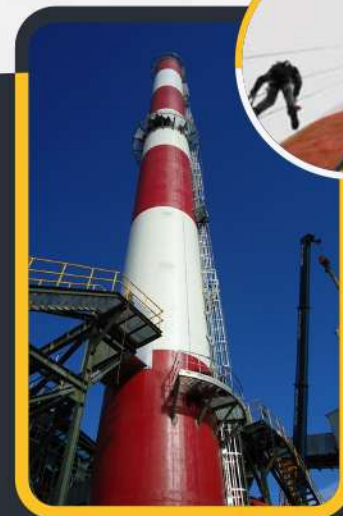
RESTAURACIÓN CIVIL, METALMECÁNICA Y PINTURA CHIMENEA
